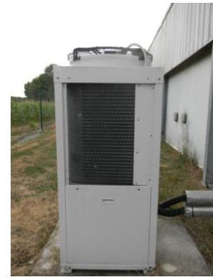
Figure 14: Centrale de traitement de l'air
