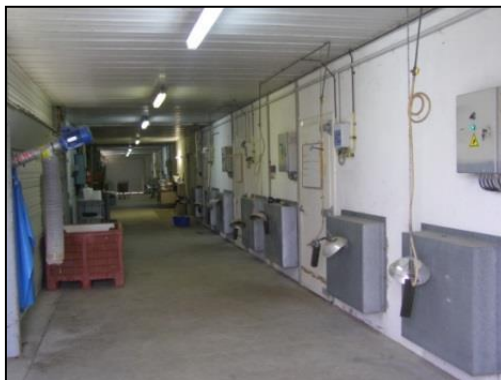
Figure 6: Bâtiment 16. Couloir d'accès aux loges.
