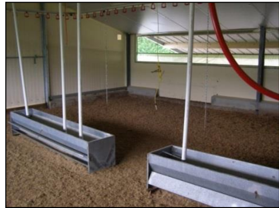
Figure 26: L'intérieur du bâtiment "Louisiane" du Palmipôle
