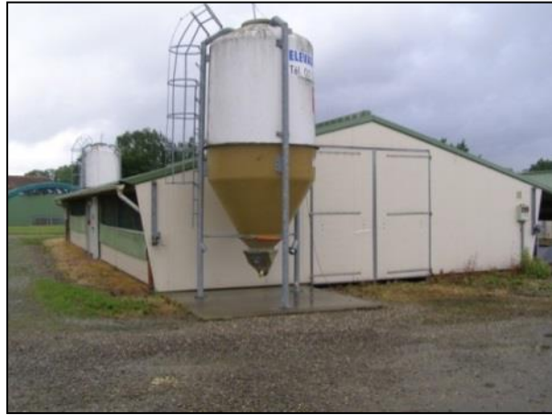
Figure 24: Bâtiment de type Louisiane démarrage des canetons
