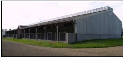
Figure 18: Bâtiment 36 vue de l'aire extérieure
